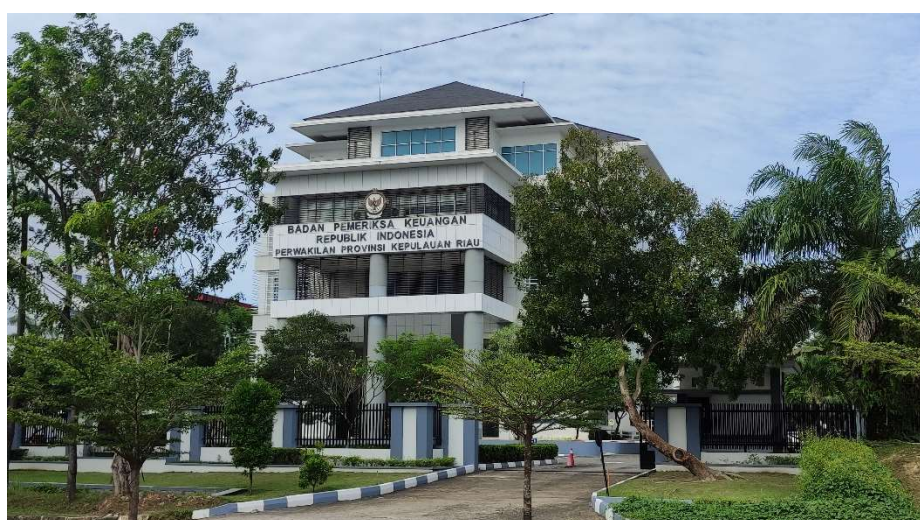
Gambar 1.1 Gedung BPK Perwakilan Provinsi Kepulauan Riau
